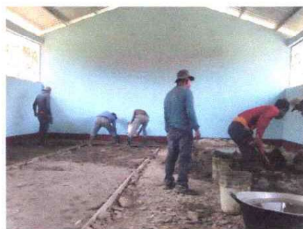
FOTO 6: SUSTITUCIÓN DE PISO DE TORTA DE CONCRETO
