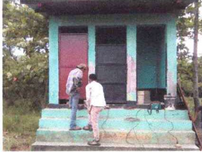
FOTO 7: SUSTITUCIÓN DE PUERTAS DE SERVICIOS SANITARIOS
