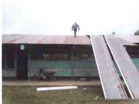
FOTO 1: SUSTITUCION DE LÁMINA, POR LÁMINA TROQUELADA ALUZINC
