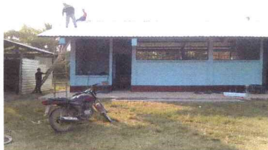
FOTO 2: SUSTITUCION DE LÁMINA POR LÁMINA TROQUELADA ALUZINC
