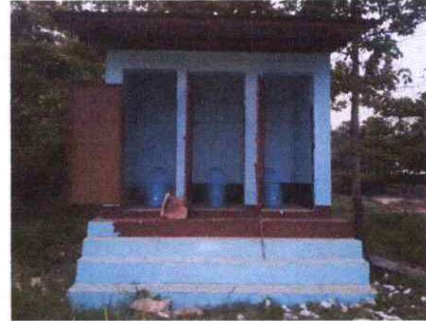
FOTO 8: SUSTITUCION DE INODOROS
