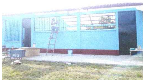
FOTO 5: SUSTITUCIÓN DE PUERTAS
