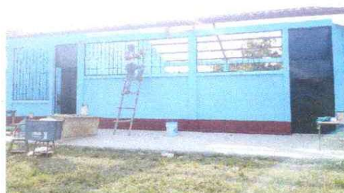
FOTO 4: SUSTITUCION DE BALCONES DE METAL
