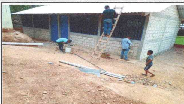
Foto 2: SUSTITUCION DE VENTANAS DE MADERA POR BALCONES DE METAL, SUSTITUCION DE PUERTAS DE MADERA POR PUERTAS DE METAL
