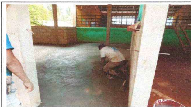
FOTO 4. SUSTITUCION DE PISO
