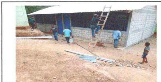
FOTO 3. SUSTITUCION Y MEJORAMIENTO DE MURO DE AULAS
