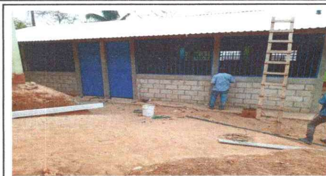
Foto1: SUSTITUCION DE ESTRUCTURA DE MADERA POR ESTRUCTURA DE METAL, SUSTITUCION DE LAMINAS ZINK, POR LAMINAS TROQUELADAS CALIBRE 26 LEGITIMAS
