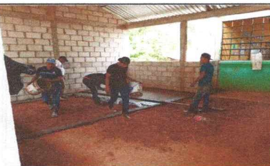
Foto 5: SUSTITUCION DE PISO DE AULA 1
