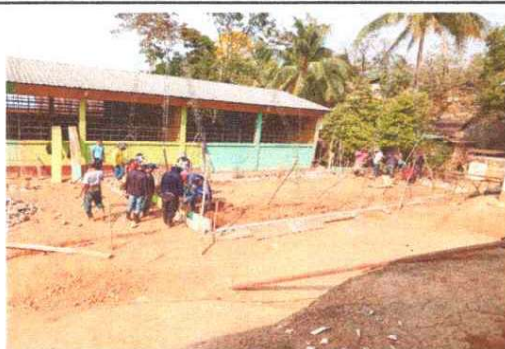
Foto 1: LEVANTAMIENTO Y MEJORAMIENTO DE MURO
