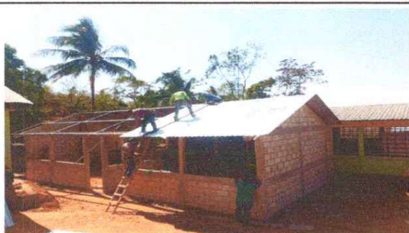
Foto 3: SUSTITUCION DE ESTRUCTURA DE MADERA POR ESTRUCTURA DE METAL Y SUSTITUCION DE LAMINAS ZINC POR LAMINAS TROQUELADAS CALIBRE 26 LEGITIMAS
