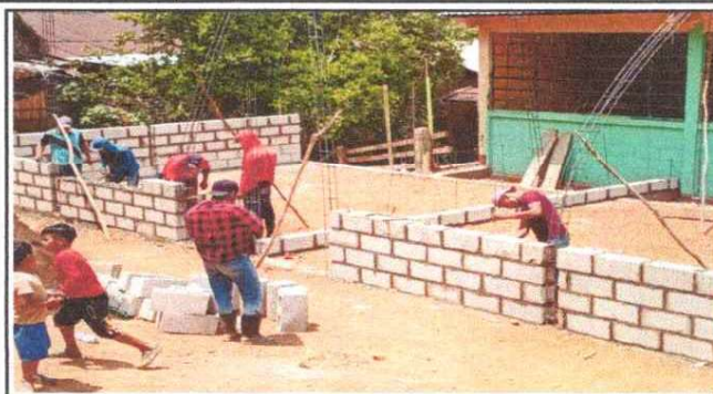
Foto 2: SUSTITUCION DE MURO MADERA POR MURO DE BLOCK
