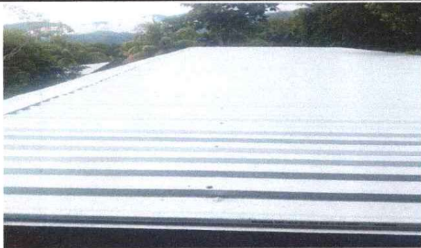
Foto1: SUSTITUCIÓN DE LÁMINAS POR LAMINAS TROQUELADAS ALUZINC CALIBRE 26.
