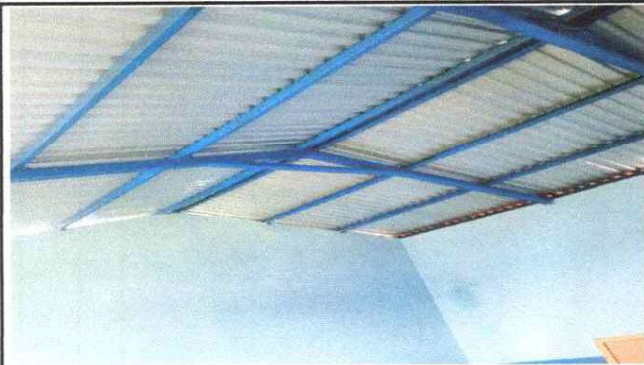
Foto 9: PINTADA DE MURO INTERIOR.
