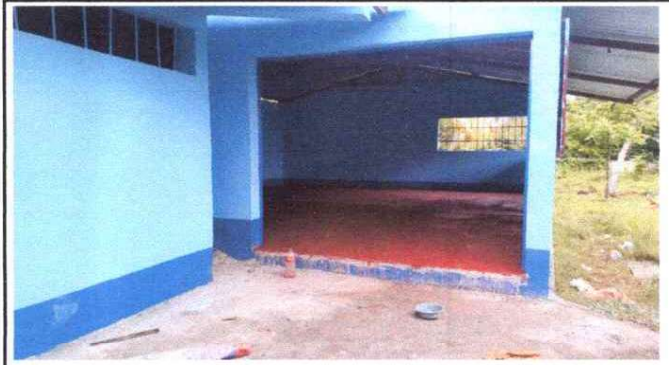
Foto 4: REPARACIÓN DE PISO DE TORTA DE CONCRETO.
