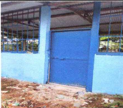
Foto 3: SUSTITUCIÓN DE PUERTA.
