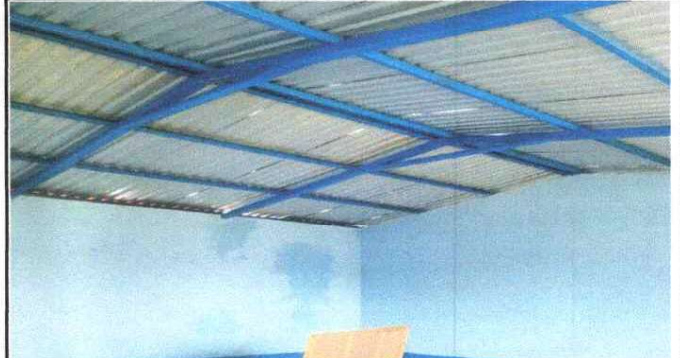
Foto 2: ,MANTENIMIENTO A ESTRUCTURA DE SOPORTE DE METAL.
