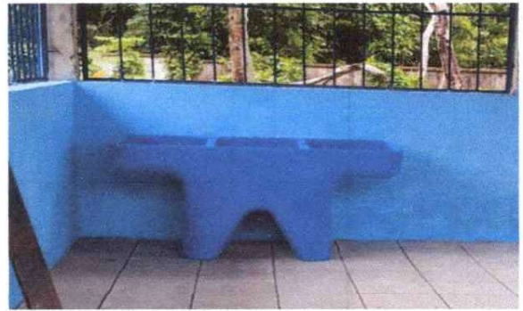
Foto 10: SUSTITUCIÓN E INSTALACIÓN DE PILA.
