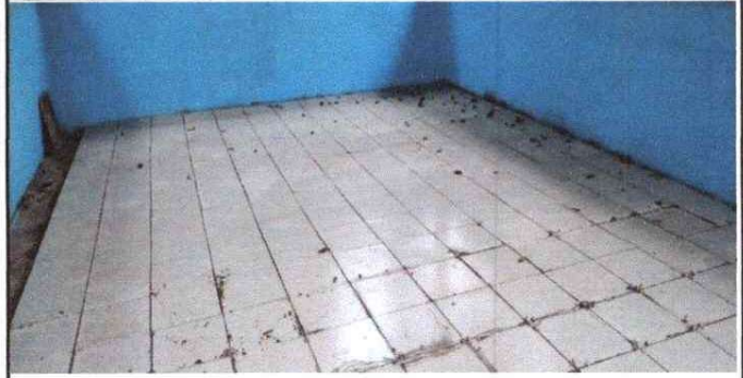
Foto 8: REPELLO DE MURO INTERIOR.
