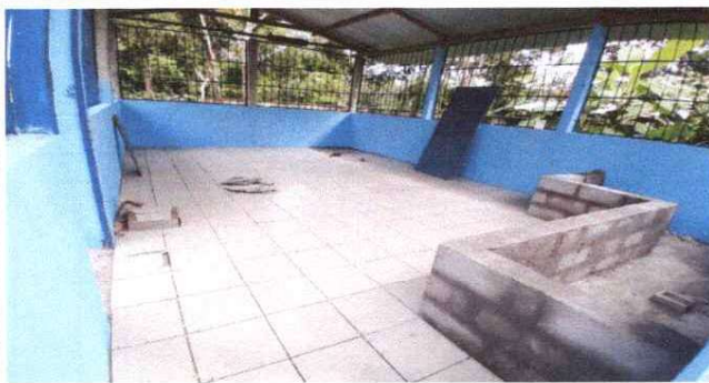
Foto 5: SUSTITUCIÓN DE PISO CERÁMICO.
