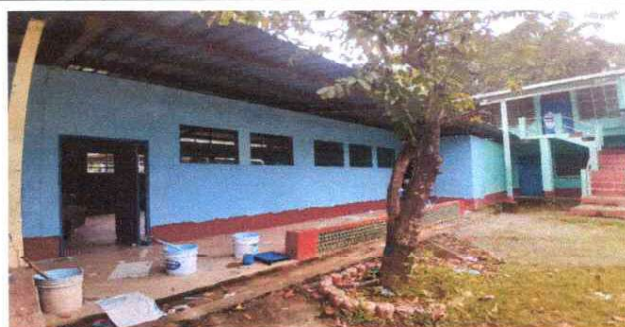
Foto 6: PINTURA EN MUROS EXTERIORES.
