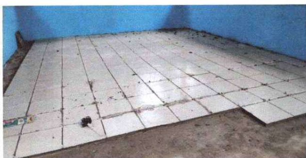
Foto 5: SUSTITUCION DE PISO CERÁMICO
