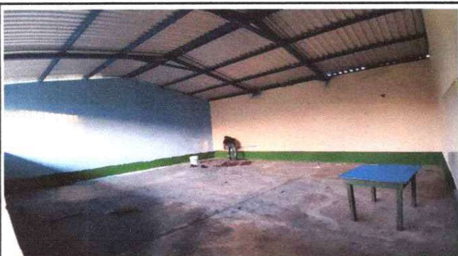
Foto 3: PINTADA DE MURO INTERIOR.
