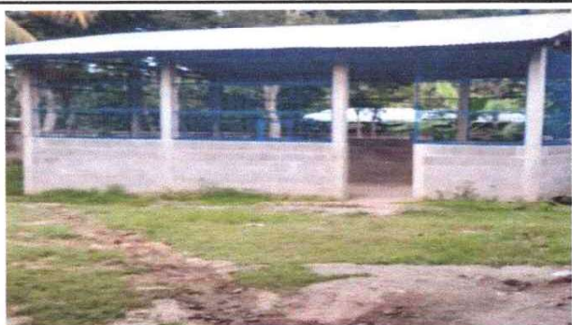
Foto1: REPELLO EN MURO EXTERIOR.
