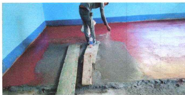
Foto 4: REPARACION DE PISO DE TORTA DE CONCRETO.
