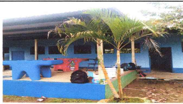
Foto 4: SUSTITUCION E INSTALACIÓN DE PILA
