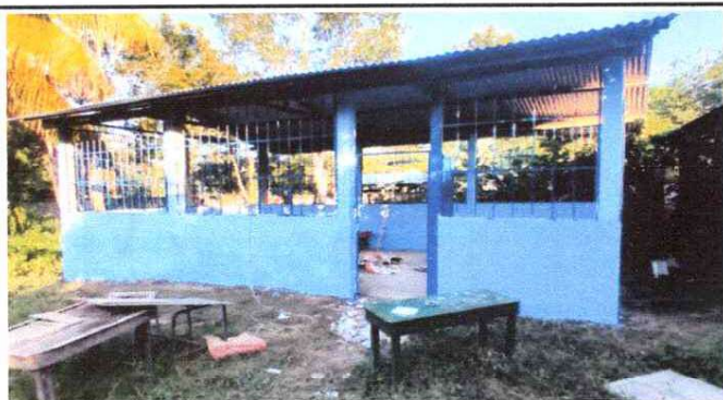
Foto 3: SUSTITUCIÓN DE PUERTA
