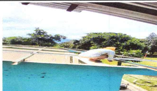
Foto 2: MANTENIMIENTO A ESTRUCTURA DE SOPORTE DE METAL
