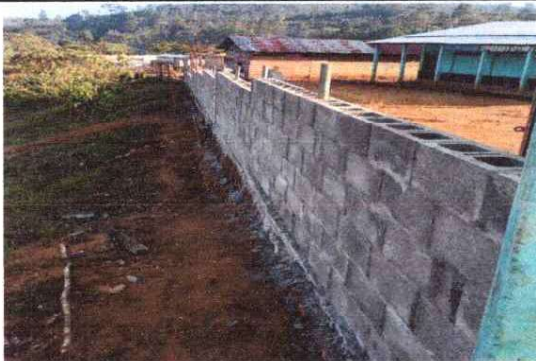
FOTO 9: Reparación de malla.
