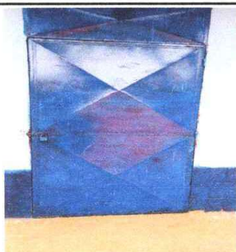
FOTO 3: Sustitución de puerta.
