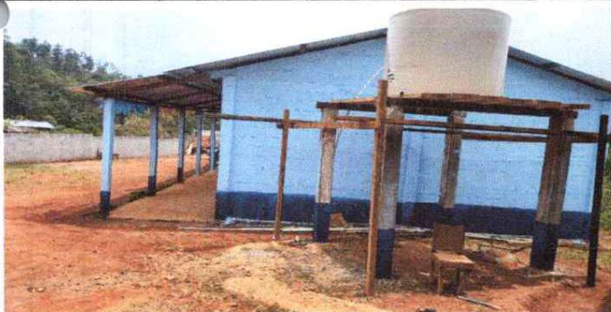
FOTO 11: Sustitución de depósito de agua.
