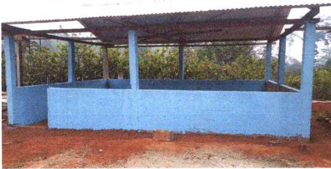
FOTO 7: Pintura en muros exteriores e interiores.
