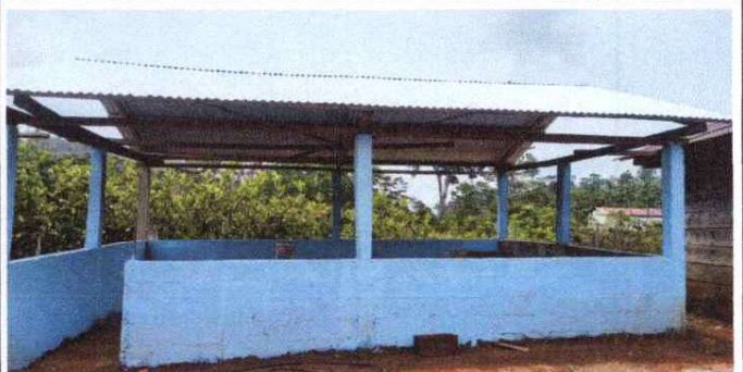
FOTO 12: Reparación de cocina.
