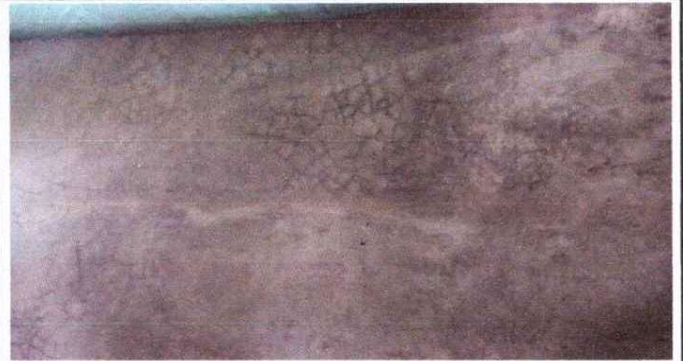
FOTO 10: Reparación de plancha de concreto de patio.
