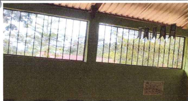
FOTO 5: Mantenimiento de balcones.
