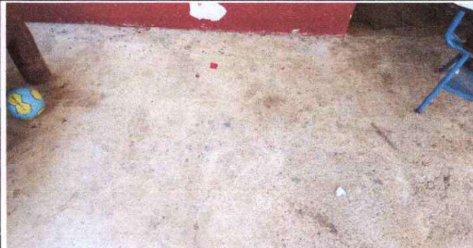
FOTO 6: Sustitución de piso de concreto.
