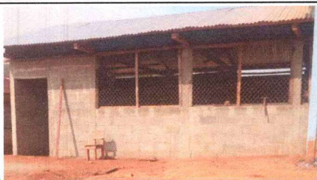
FOTO 1: Sustitución de lámina.
