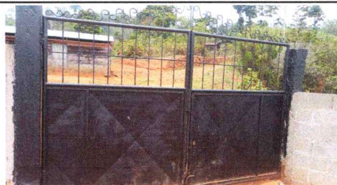
FOTO 4: Sustitución de porton de metal.
