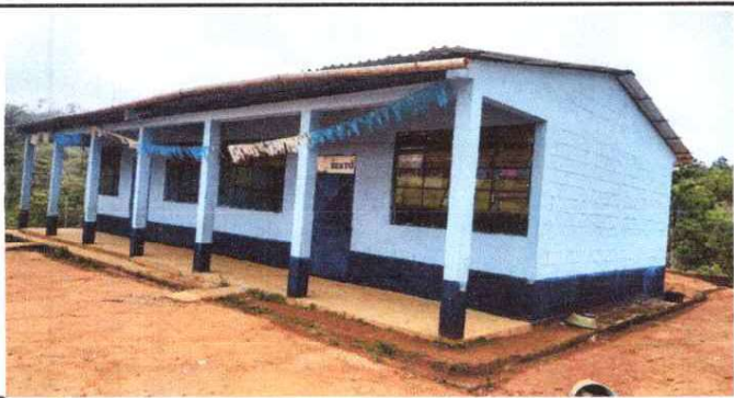
FOTO 7: Pintura en muros exteriores e interiores.
