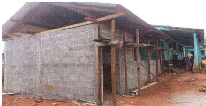
FOTO 1: Sustitución de lámina.
