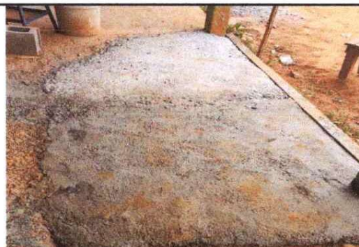
FOTO 6: Sustitución de piso de concreto.
