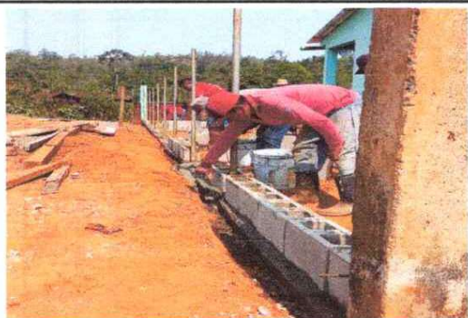
FOTO 9: Reparación de malla.
