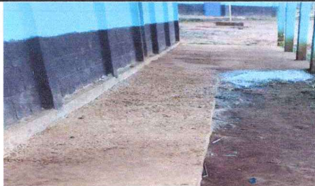
FOTO 10: Reparación de plancha de concreto de patio.
