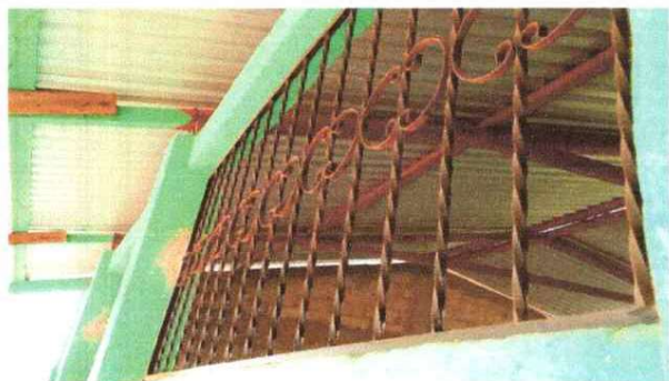
FOTO 5: Mantenimiento de balcones.
