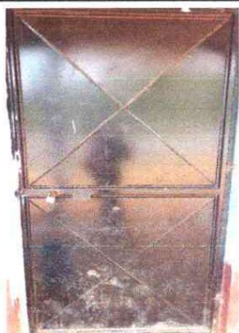
FOTO 3: Sustitución de puerta.
