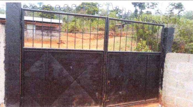
FOTO 4: Sustitución de porton de metal.
