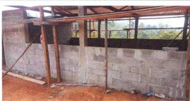
FOTO 12: Reparación de cocina.
