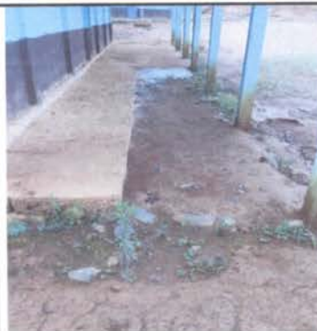
FOTO 10. REPARACION PLANCHA DE CONCRETO PATIO.
