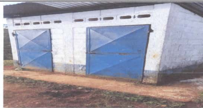
FOTO 3. SUSTITUCION DE PUERTA.
