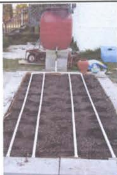
FOTO 11. SUSTITUCION DE DEPOSITO DE AGUA.
