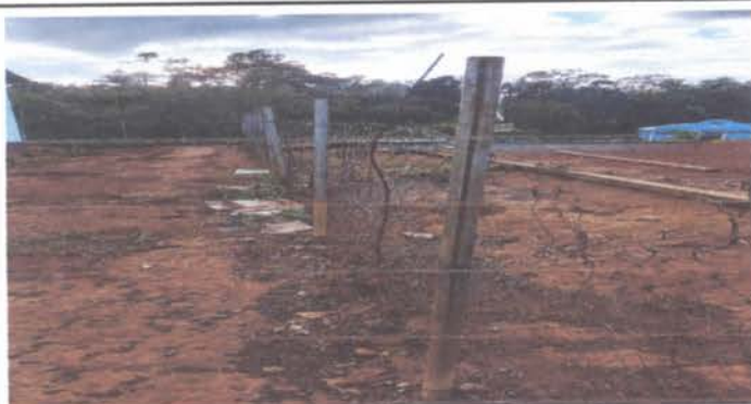
FOTO 9. REPARACION DE MALLA.
