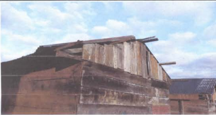
FOTO 1. SUSTITUCION DE LAMINAS
