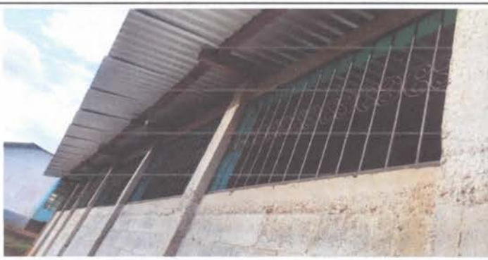
FOTO 5. MANTENIMIENTO A BALCONES.
