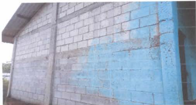
FOTO 7. PINTURA DE MUROS EXTERIORES.
