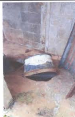
FOTO 8. SUSTITUCION DE INODORO.
