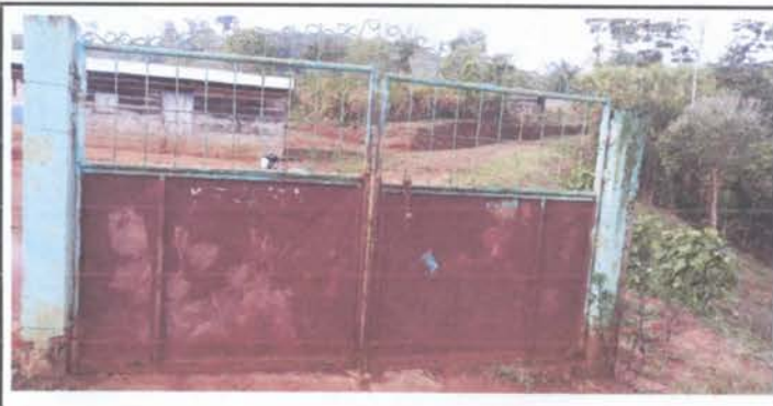
FOTO 4. SUSTITUCION DE PORTON DE METAL.
