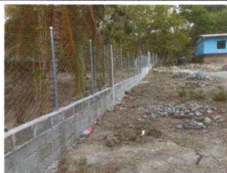
FOTO 2: Se pueden observar en la parte poniente de la escuela que los tubos y la malla están bien instalados
