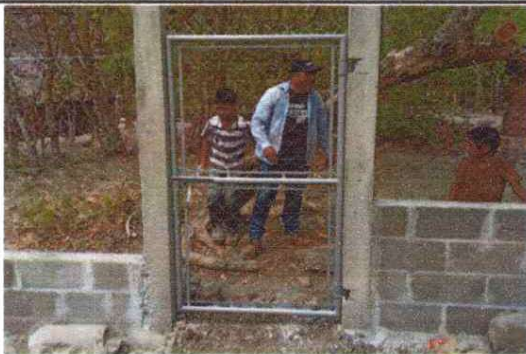
FOTO 3: Puerta de ingreso lado sur, instalado
