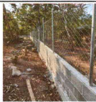
Foto 6: se puede observar la malla y los tubos bien instalados.
