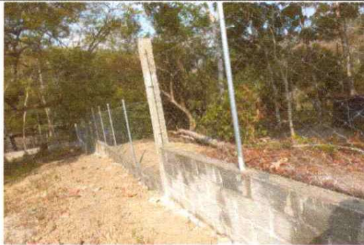
FOTO 1: Se observan las mallas y tubos instalados
