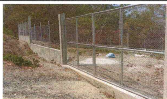
FOTO 4: Portón de ingreso de 5 metros instalado
