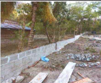
FOTO 5: Se puede observar el avance del pegado de block y soleras u
