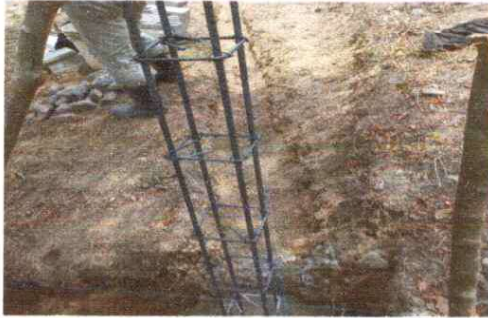
FOTO 1: Se observa proceso de centrado y cimentación de columnas
