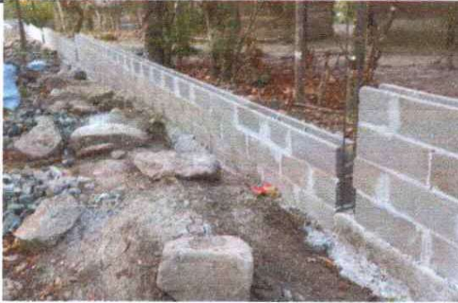
FOTO 4: Avance en el pegado de block en un 70%
