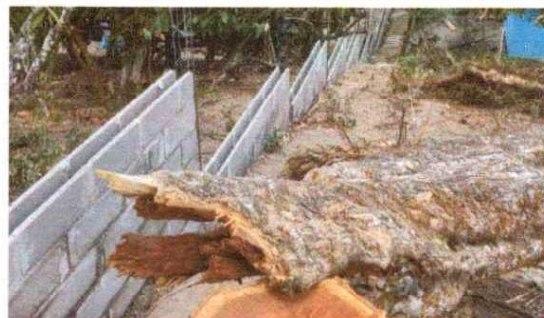
FOTO 6: Se observan la cantidad de gradas y columnas que se construyeron debido al terreno con mucha pendiente
