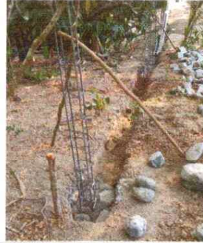
FOTO 2: Se puede observar el Zanjeo y cimentación de columnas
