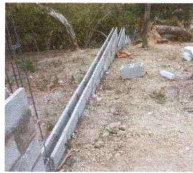
FOTO 4: Se observan las soleras U ya pegadas
