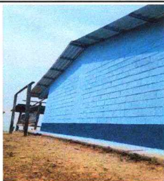
Foto 3: FINALIZACION SUSTITUCIÓN DE ESTRUCTURA
