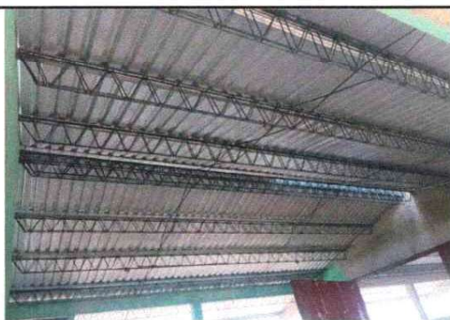
Foto 5: FINALIZACIÓN DE SUSTITUCIÓN DE ESTRUCTURA DE TECHO
