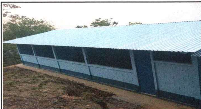
Foto1: FINALIZACION DE SUSTITUCIÓN DE ESTRUCTURA DE TECHO
