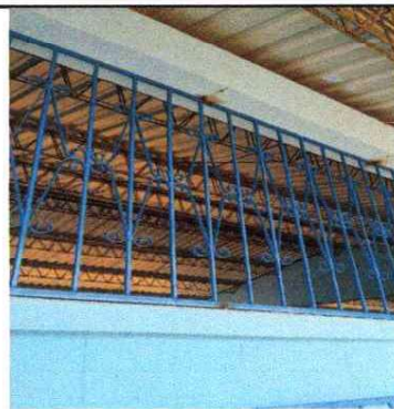
Foto 2: FINALIZACION SUSTITUCION DE VENTANAS
