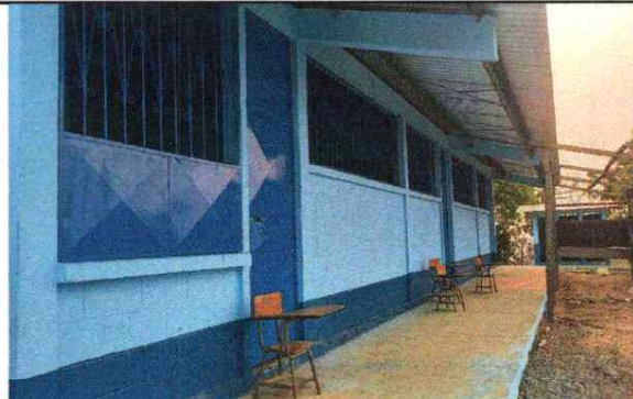
Foto 4: FINALIZACION DE SUSTITUCIÓN DE PUERTAS
