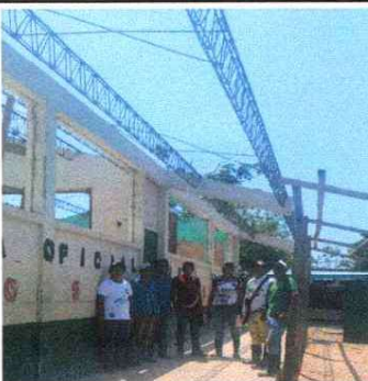
Foto 5: SUSTITUCION DE ESTRUCTURA METALICA
