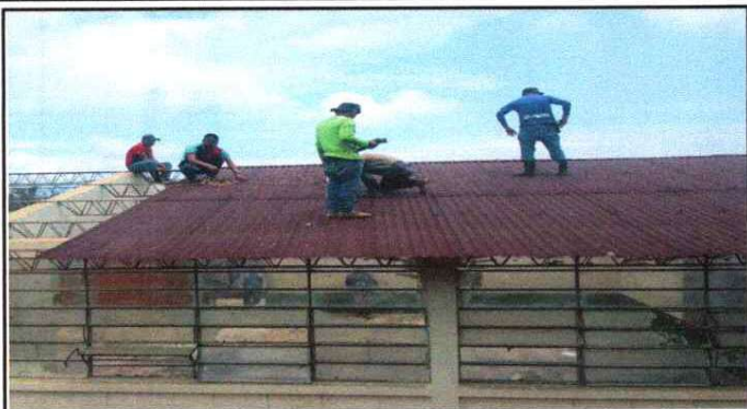
Foto1: SUSTITUCIÓN DE ESTRUCTURA DE TECHO
