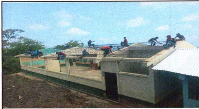
Foto 2: SUSTITUCIÓN DE ESTRUCTURA DE TECHO
