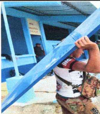
Foto 3: SUSTITUCION DE PUERTAS
