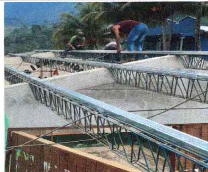
Foto 6: FINALIZACIÓN DE SUSTITUCIÓN DE ESTRUCTURA DE TECHO
