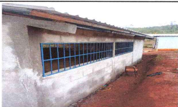
FOTO 5: INSTALACIÓN DE BALCONES DE METAL.
