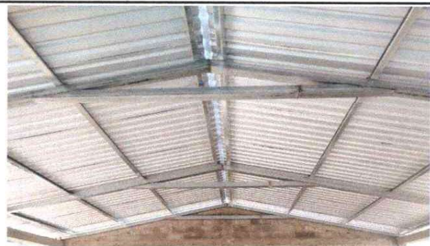
FOTO 3: INSTALACIÓN DE ESTRUCTURA METALICA.
