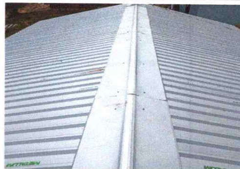
FOTO 2: INSTALACIÓN DE LAMINA TROQUELADA.
