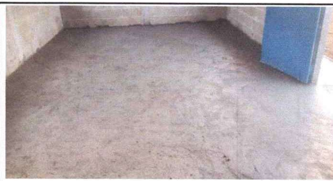
FOTO 6: SUSTITUCIÓN DE PISO DE CONCRETO.
