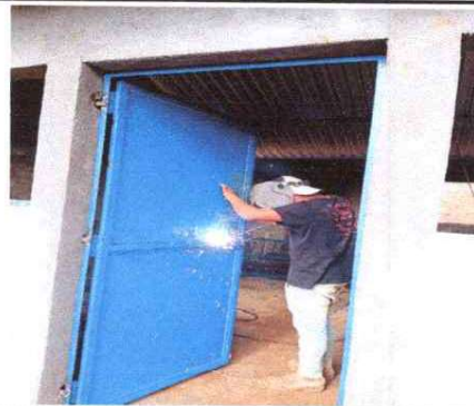
FOTO 4: INSTALACIÓN DE PUERTA METALICA.
