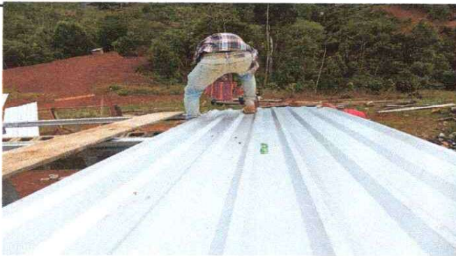
FOTO 3: SUSTITUCIÓN DE LAMINA TROQUELADA.
