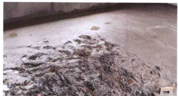
Foto 6: SUSTITUCIÓN DE PISO DE CONCRETO.
