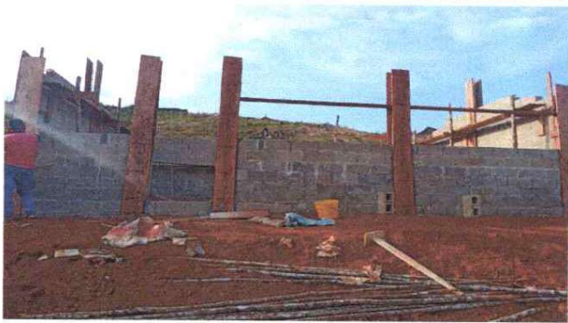
FOTO 1: LEVANTAMIENTO DE COLUMNA DE CONCRETO.
