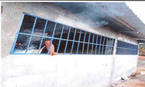
Foto 5: INSTALACIÓN DE BALCONES DE METAL.
