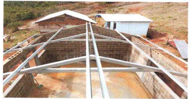
FOTO 2: SUSTITUCIÓN DE ESTRUCTURA METALICA.
