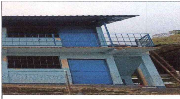
FOTO 4: FABRICACIÓN E INSTALACIÓN DE 2 PUERTAS DE METAL.
