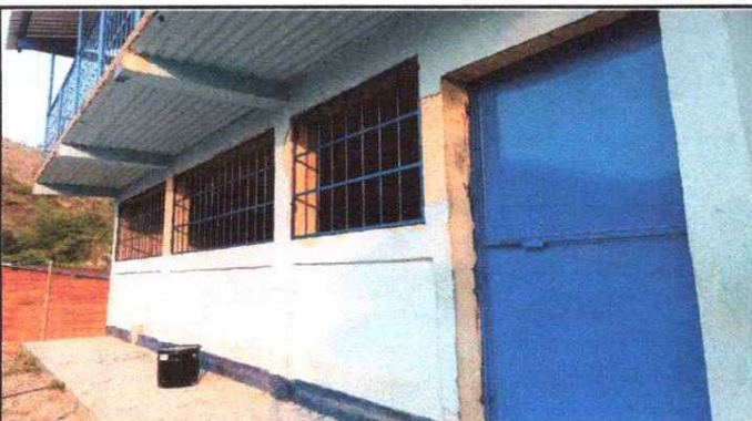
FOTO 3: FABRICACIÓN E INSTALACIÓN DE BALCONES DE METAL
