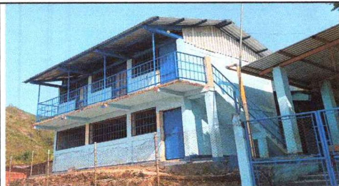
FOTO 1: FABRICACIÓN E INSTALACIÓN DE ESTRUCTURAS METALICA, INSTALACIÓN DE LAMINAS TROQUELADAS.
