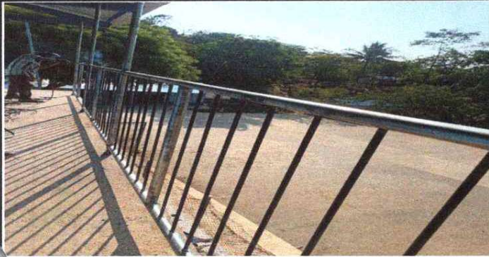
FOTO 7: FABRICACIÓN E INSTALACIÓN DE BARRANDA DE METAL.
