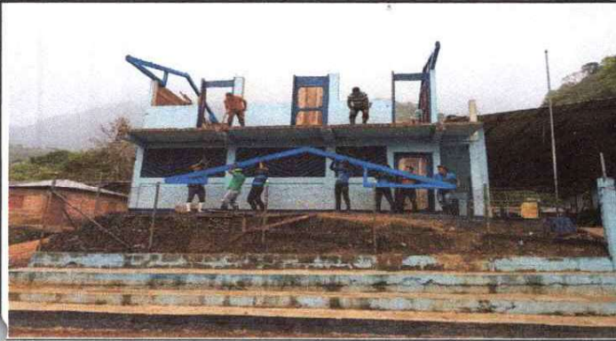
FOTO 1: FABRICACIÓN E INSTALACIÓN DE ESTRUCTURAS METALICAS AULA 1.
