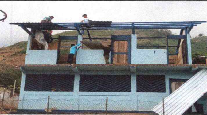
FOTO 3: INSTALACIÓN DE LAMINAS TROQUELADAS AULA 1.
