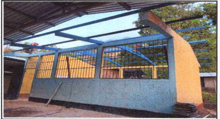
FOTO 2: FABRICACIÓN E INSTALACIÓN DE ESTRUCTURA METALICA AULA 2.
