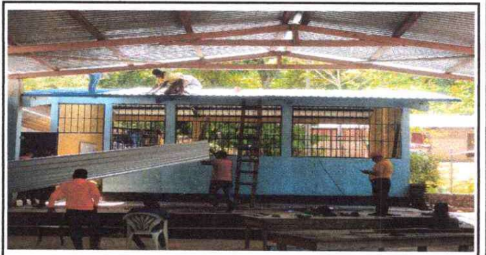
FOTO 4: INSTALACIÓN DE LAMINAS TROQUELADAS AULA 2.
