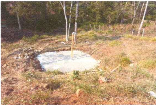
FOTO 9: Construcción de fosa séptica
