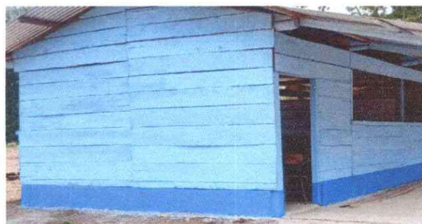
FOTO 4: Sustrucción de tablas de pared por dos hiladas de block
