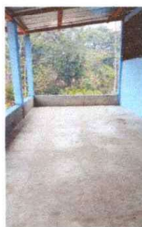
FOTO 6: Sustrucción de piso de torta de concreto Módulo 1
