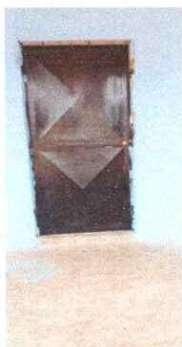
FOTO 1: Sustrucción de puerta de metal
