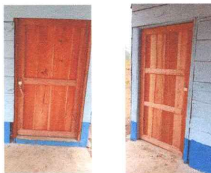
FOTO 2: Sustrucción de dos puertas de madera
