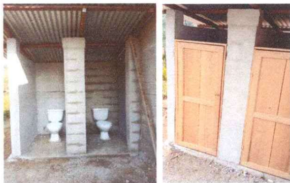
FOTO 3: Construcción de baños con tazas y puertas nuevas
