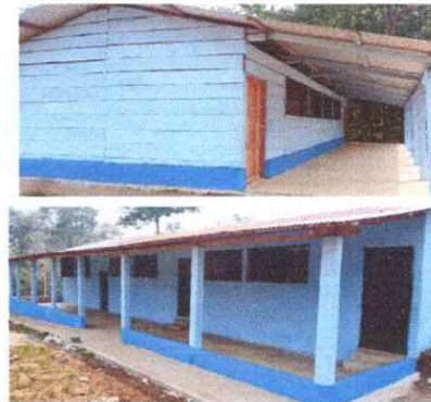
FOTO 10: Pintura en exteriores Módulo 1 y 2
