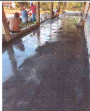
FOTO 6: Sustrución de piso de torta de concreto módulo 1
