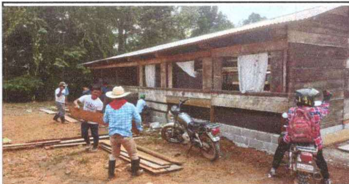
FOTO 4: Sustrución de 2 tablas de pared con dos hiladas de block módulo 2
