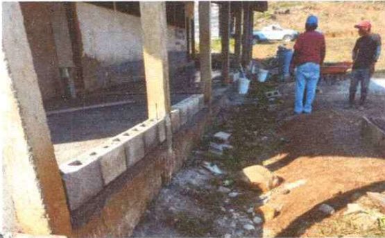
FOTO 7: PEGADO DE 2 HILADAS DE BLOCK EN EL CORREDOR DEL MÓDULO 1
