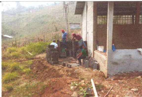
FOTO 3: Construcción de dos baños
