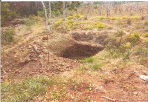
FOTO 9: CONSTRUCCIÓN DE FOSA SÉPTICA
