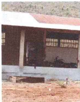
FOTO 1: Sustrución de puertas de metal
