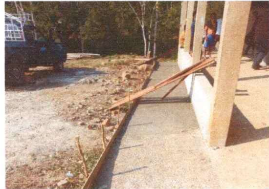
FOTO 8: FUNDICIÓN DE BANQUETAS
