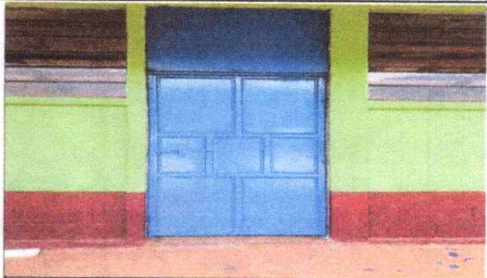
FOTO 2: Sustrucción de puertas principales.
