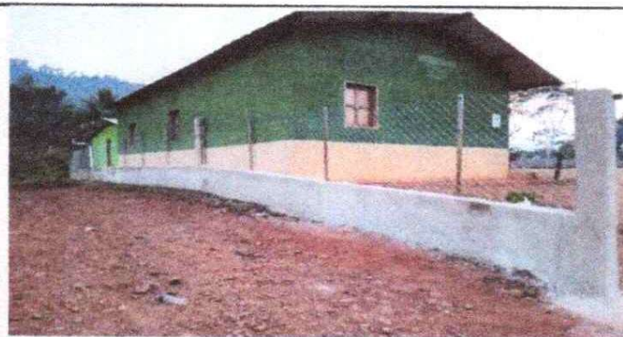
FOTO 4: Remodelación del muro perimetral.
