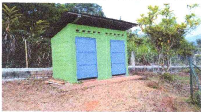
FOTO 3: Sustrucción de Puertas de servicios sanitarios.
