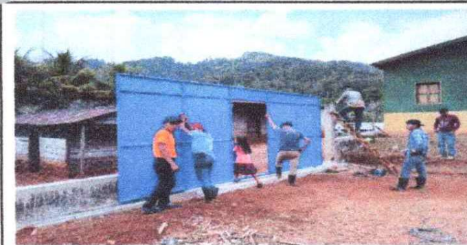
FOTO 5: Instalación del porton corredizos.
