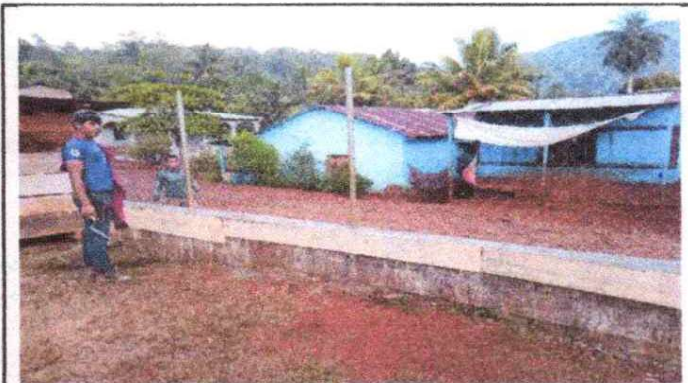
FOTO 4: Reparación del muro Perimetral.
