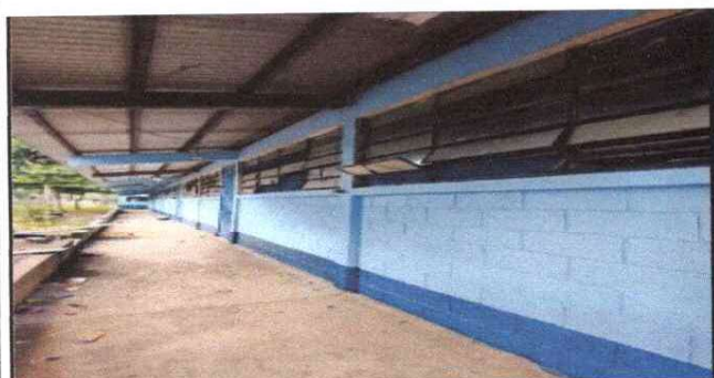
FOTO 5: PINTURA EN EXTERIOR E INTERIOR
