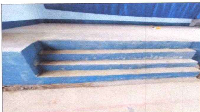
FOTO 4 :SUSTITUCION DE PISO DE CONCRETO
