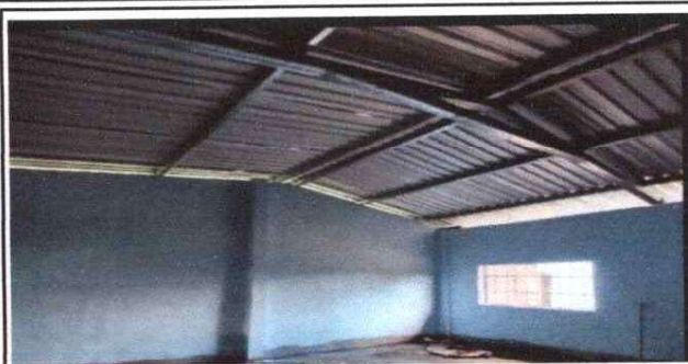
FOTO 2 : SUSTITUCION DE ESTRUCTURA DE MADERA POR METAL
