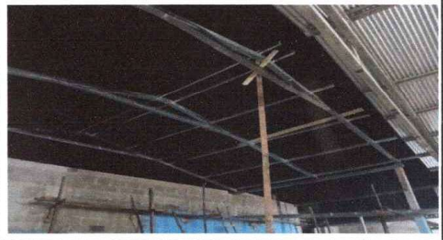
FOTO 2: SUSTITUCION DE ESTRUCTURA DE MADERA POR METAL
