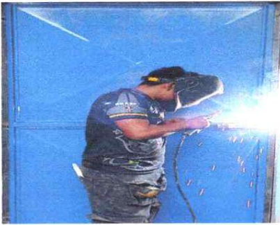
FOTO 3: SUSTITUCION DE PUERTA
