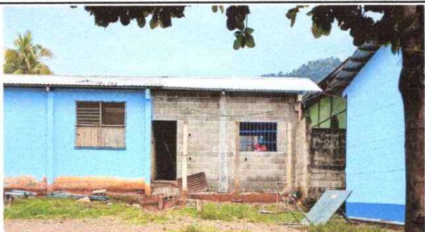
FOTO 7:SUSTITUCIÓN DE BALCON.
