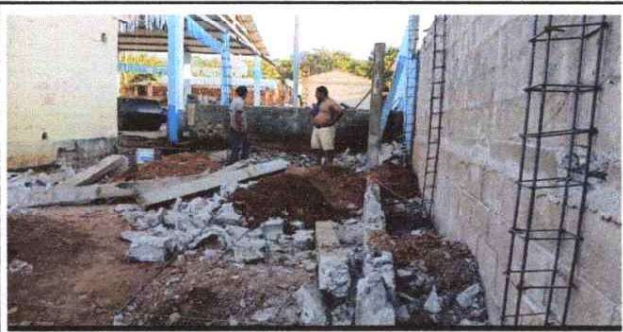
FOTO 6: CONSTRUCCION DE DOS PARES DE LA DIRECCION paredes.
