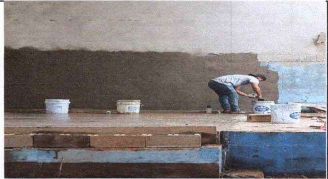
FOTO 4: SUSTITUCION DE PISO DE CONCRETO
