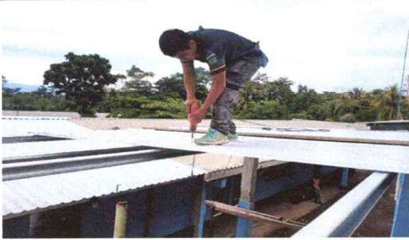
FOTO 1: SUSTITUCION DE LAMINA TROQUELADA
