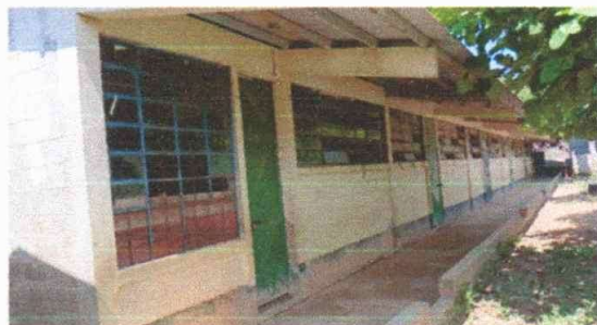
Foto 5: Pintura en muros exteriores e interiores
