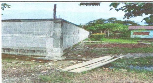
Foto 3: cambia de blok y malla de 111 metros de largo por muro de block
