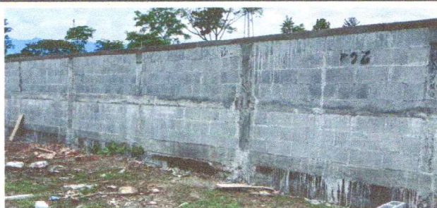
Foto 2: cambio de blok y malla de 49 metros de largo por muro de block
