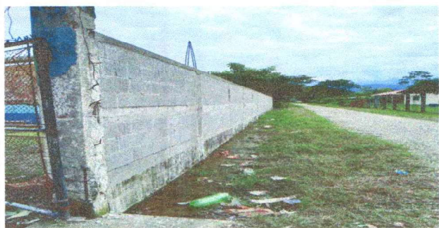
Foto 1: Cambio de block malla de 42 metros de largo por muro de block
