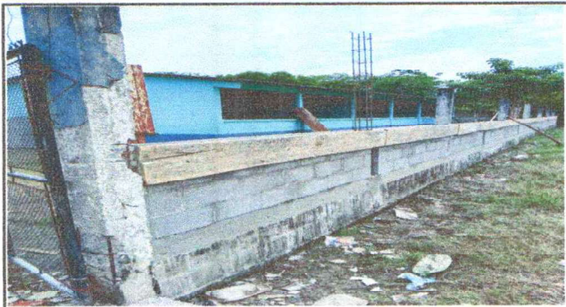
Foto 1: Cambio de block y malla de 42 metros de largo por muro de block
