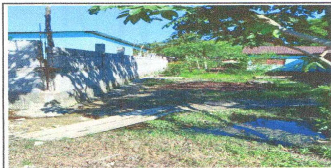
Foto 3: cambia de blok y malla de 111 metros de largo por muro de block
