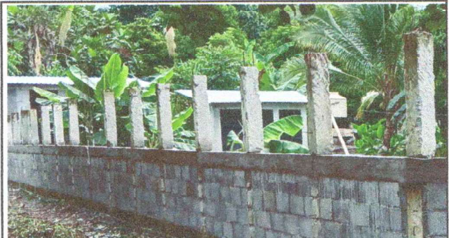
Foto 2: cambio de blok y malla de 49 metros de largo por muro de block
