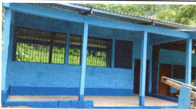
Foto 3: Levantamiento de aula de parvulos.
