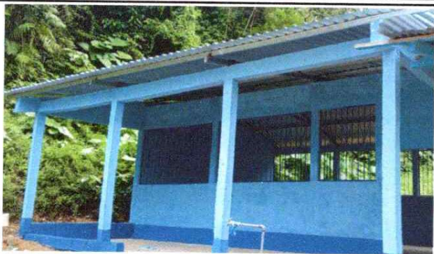
Foto1: Levantamiento de aula de parvulos.
