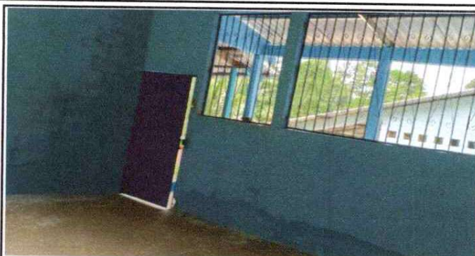
Foto 2: Levantamiento de aula de parvulos.
