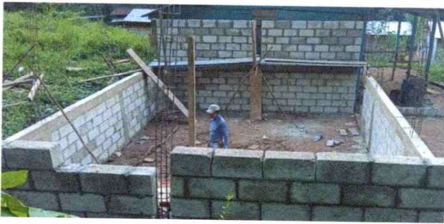
Foto 3: Levantamiento de aula de parvulos.
