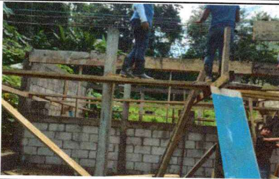
Foto1: Levantamiento de aula de parvulos.
