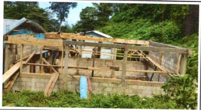
Foto 2: Levantamiento de aula de parvulos.
