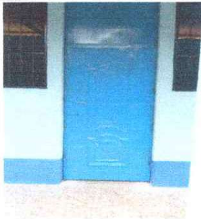
Foto 1: Finalización de cambio de puertas de maderas por puertas de metal.
