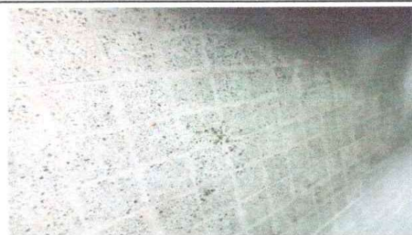
Foto 3: Finalización de cambio de piso de torta de concreto por piso de granito
