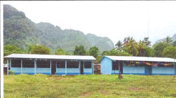
Foto 4: Finalización de pintura en muros exterior e interior
