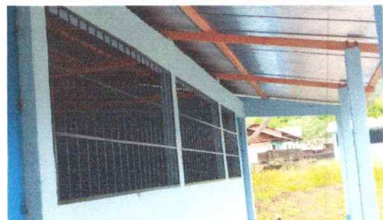
Foto 2: Finalización de cambio de balcones de madera por metal.
