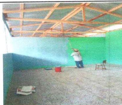
Foto 4: Proceso de pintura en muros exterior e interior
