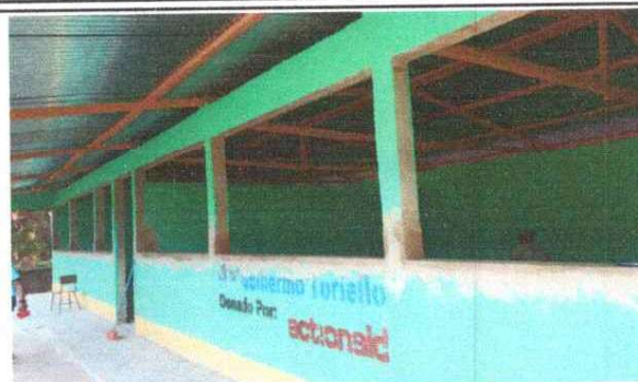
Foto 2: Sustituyendo los balcones de madera por metal.
