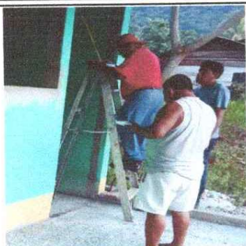
Foto1: Sustituyendo las puertas de maderas por puertas de metal.
