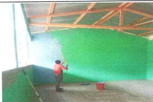
Foto 5: Proceso de pintura en muros exterior e interior
