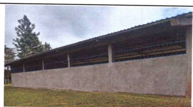
Foto 6: REPELLO DEL MURO DE CONTENCIÓN.
