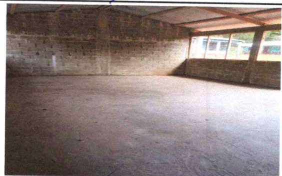
Foto 4: COLOCACIÓN DE PISO DE COCINA.
