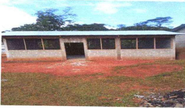
Foto 1 :COSTRUCIÓN DE COCINA.
