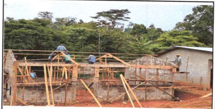
Foto 2: COLOCACIÓN DE ESTRUCTURA DE MADERA DE COCINA.
