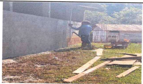
Foto 6: REPELLO DEL MURO DE CONTENCIÓN.
