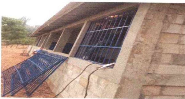
Foto 5. COLOCACIÓN DE BALCONES DE METAL.
