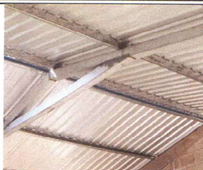
Foto 2: ESTRUCTURA DE SOPORTE DE TECHO DE METAL
