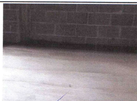
Foto 4: SUSTITUCIÓN DE PISO DE TORTA DE CONCRETO
