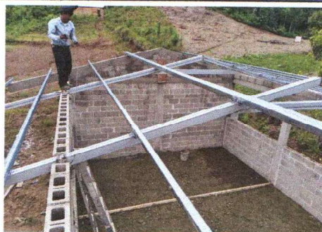
Foto 2: Fabricación e instalación de estructuras de techo
