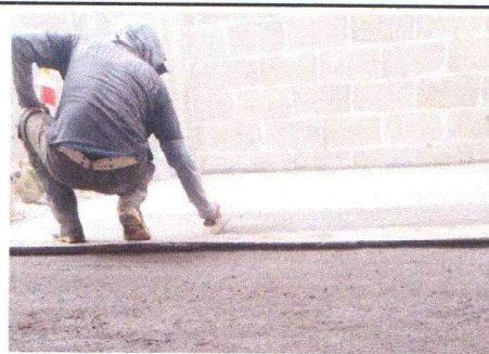
Foto 4: Fundición y alisado de piso de torta de concreto
