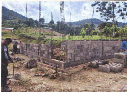
Foto 1: Construcción de paredes y columnas
