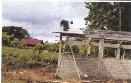
Foto 3: INSTALACIÓN DE LÁMINAS TROQUELADAS ALUZINC CALIBRE 26
