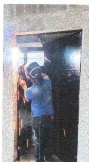
Foto 5: INSTALACIÓN DE PUERTA DE METAL
