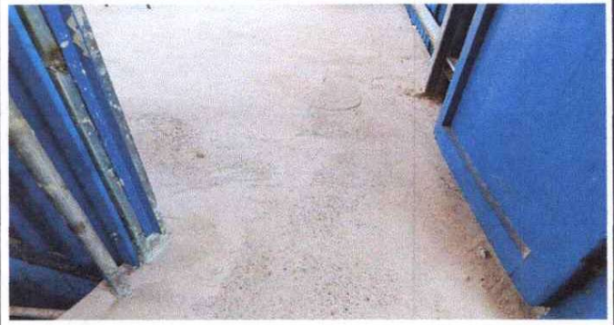
Foto 2: Reparación de piso de torta de concreto-
