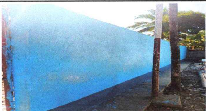
Foto 3: Repello en muro.
