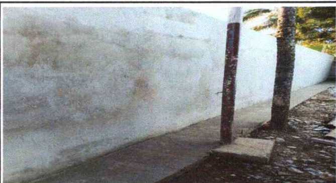
Foto 3: Repello en muro.
