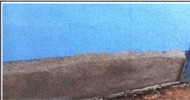
Foto 4: Sellado de grietas y fisuras en muros.
