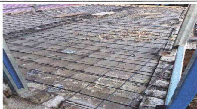
Foto 2: Reparación de piso de torta de concreto-
