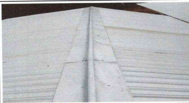
Foto1: CUBIERTA DE LAMINA
