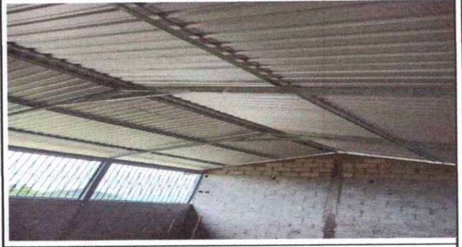
Foto 2: ESTRUCTURA DE SOPORTE DE METAL
