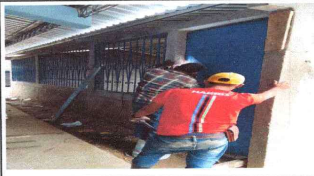
Foto 4: PUERTAS Y BALCONES
