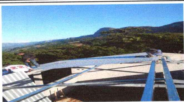
Foto 1: CUBIERTA DE LAMINA TROQUELADA ALIZINK CALIBRE 26
