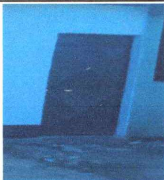
Foto 3: SUSTITUCION DE PUERTA DE MADERA POR METAL
