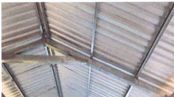
FOTO 1: SUSTITUCION DE ESTRUCTURA DE MADERA POR METAL
