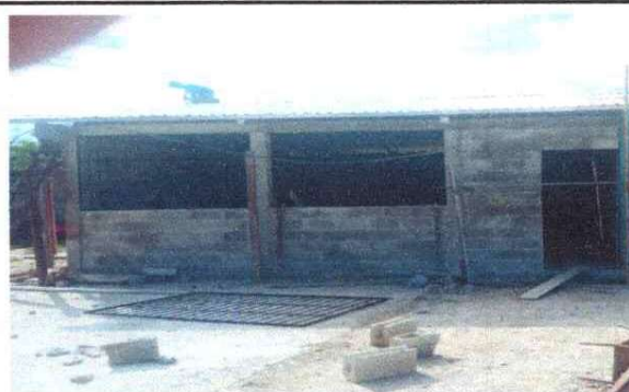
Foto 2: SUSTITUCIÓN DE LAMINAS ZINC POR LAMINA TROQUELADA
