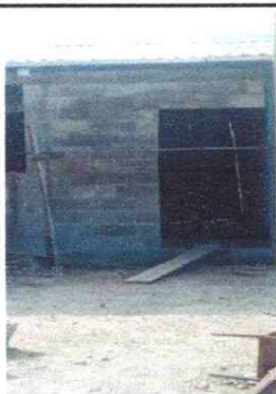
FOTO 4: SUSTITUCIÓN DE PUERTA DE MADERA POR METAL
