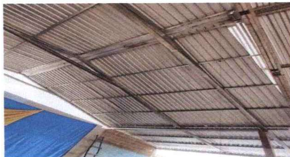
FOTO 2: SUSTITUCION DE ESTRUCTURA DE MADERA POR METAL
