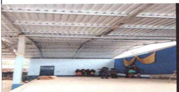
FOTO 1: SUSTITUCION DE LÁMINA POR LAMINA TROQUELADA
