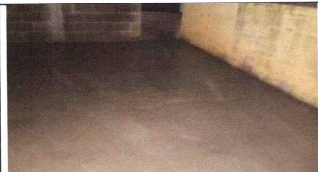
FOTO 5: SUSTITUCION DE PISO
