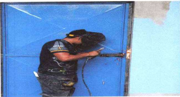
FOTO 3: SUSTITUCION DE PUERTA
