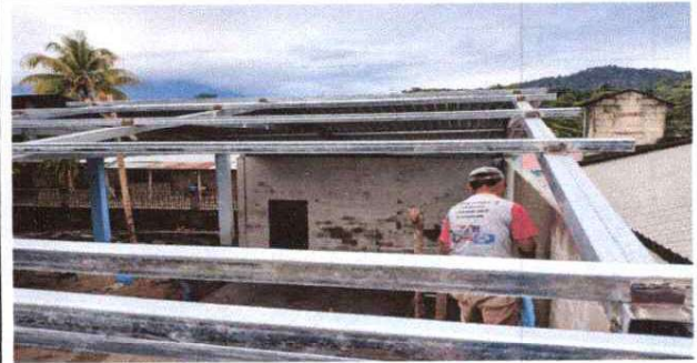
FOTO 2: SUSTITUCION DE ESTRUCTURA DE MADERA POR METAL
