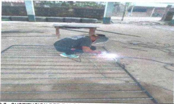
FOTO 7 : SUSTITUCION DER BALCONES DE METAL
