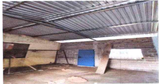
FOTO 4: LEVANTAMIENTO DE DOS PAREDES DE CAMERINO DEL ESCENARIO
