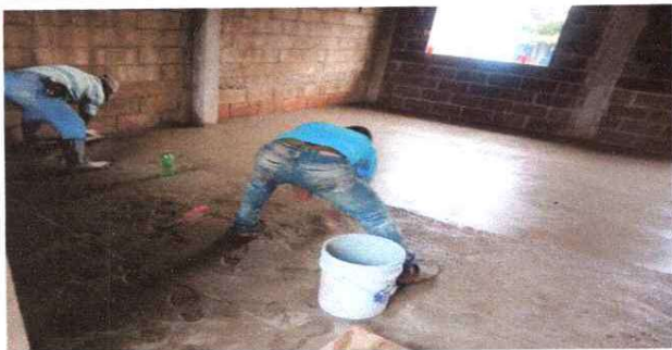
FOTO 5: SUSTITUCION DE PISO
