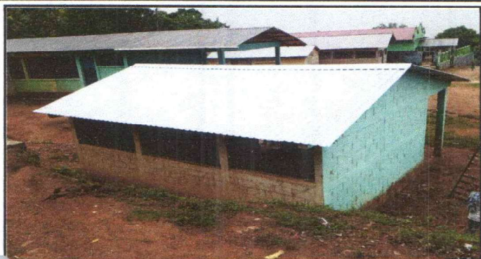
Foto 1: SUSTITUCIÓN DE LAMINA POR LAMINA TROQUELADA ALUZINC CALIBRE 26 Y ESTRUCTURA DE SOPORTE DE LAMINA. MODULO 1
