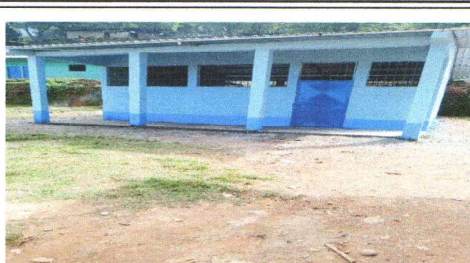
Foto 2: SUSTITUCIÓN DE LAMINA POR LAMINA TROQUELADA ALUZINC CALIBRE 26 Y ESTRUCTURA DE SOPORTE DE LAMINA. MODULO 1
