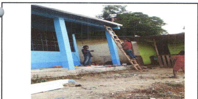
Foto 5. SUSTITUCION DE CANALES PLUVIALES
