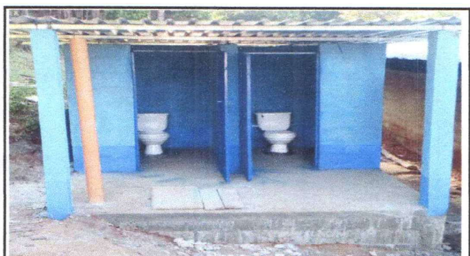
Foto 3: CONSTRUCCION DE SERVICIO SANITARIO (INODORO)
