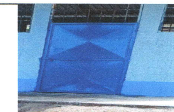
Foto 4: SUSTITUCIÓN DE PUERTA
