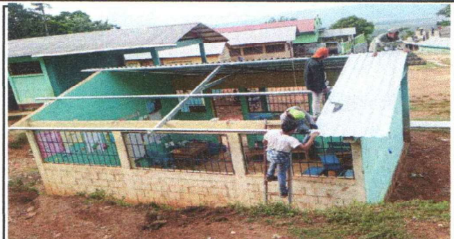
Foto 2: SUSTITUCIÓN DE LAMINA POR LAMINA, TROQUELADA ALUZINC CALIBRE 26 Y ESTRUCTURA DE SOPORTE DE LAMINA. MODULO 1
