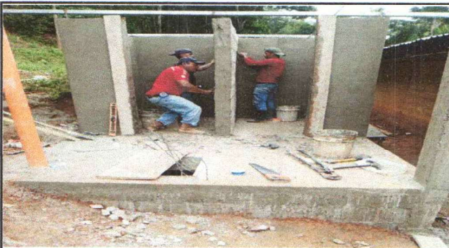
FOTO 4: CONSTRUCCIÓN DE SERVICIO SANITARIO (INODORO)
