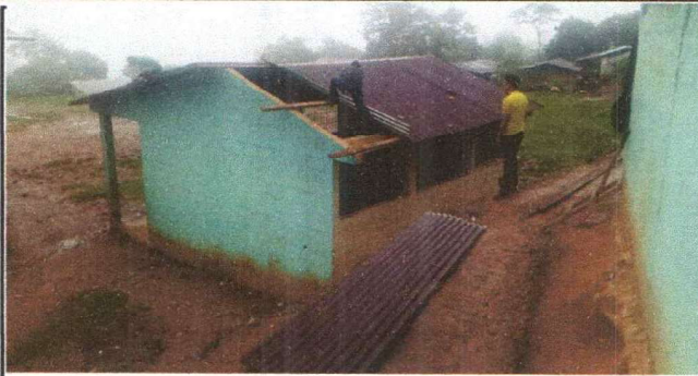
Foto 1: SUSTITUCIÓN DE LAMINA POR LAMINA, TROQUELADA ALUZINC CALIBRE 26 ESTRUCTURA DE SOPORTE DE LAMINA. MODULO 1
