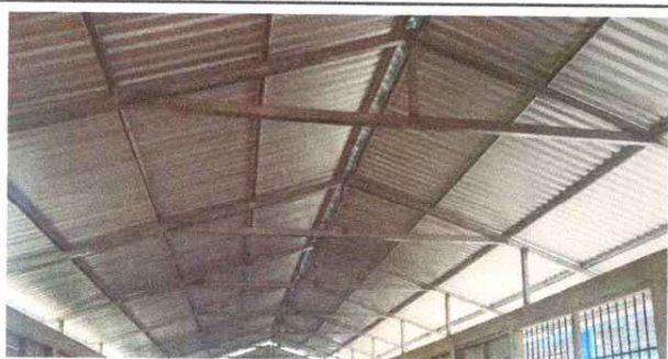
Foto 3 Finalización de cambio de estructura de soporte de madera, por metal
