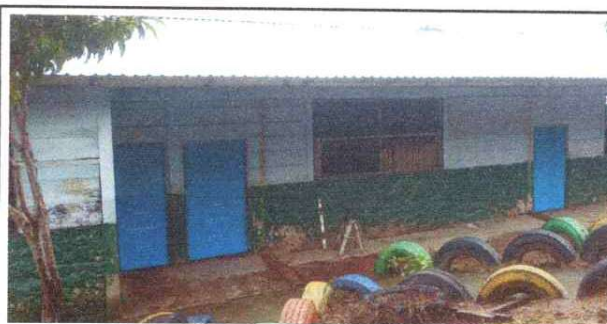
Foto 6: Finalización de cambio de puertas
