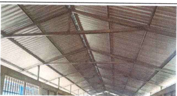
Foto 4: Finalización de cambio de estructura de soporte de madera, por metal
