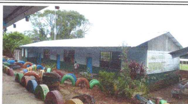
Foto 2: Finalización de cambio de lámina, por lámina troquelada aluzinc calibre 26
