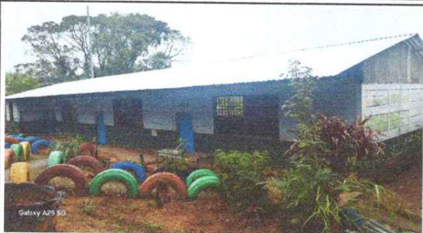
Foto1: : Finalización de cambio de lámina, por lámina troquelada aluzinc calibre 26
