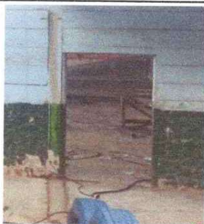
Foto 5: Sustrucción de puertas
