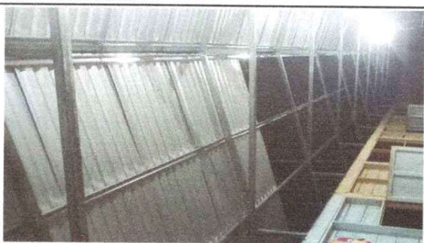
Foto 3 Sustrucción de estructura de soporte de madera, por metal
