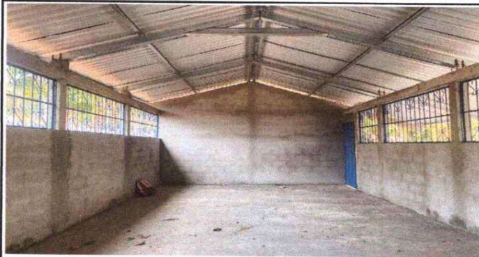
FOTO 2: SUSTITUCIÓN DE ESTRUCTURA DE MADERA POR METAL.
