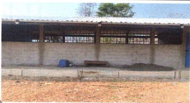
FOTO 1: REMODELACIÓN Y LEVANTAMIENTO DEL MURO DE AULA.
