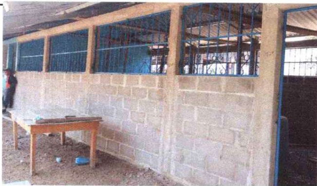
FOTO 3: SUSTITUCIÓN DE VENTANAS DE MALLA POR BALCONES
