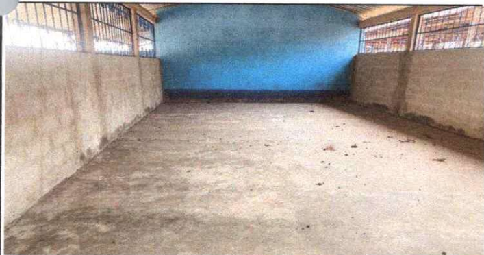
FOTO 5: REPARACIÓN DE PISO DE TORTA DE CONCRETO.
