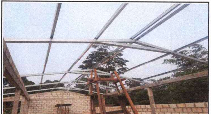
FOTO 2: SUSTITUCIÓN DE ESTRUCTURA DE MADERA POR METAL.
