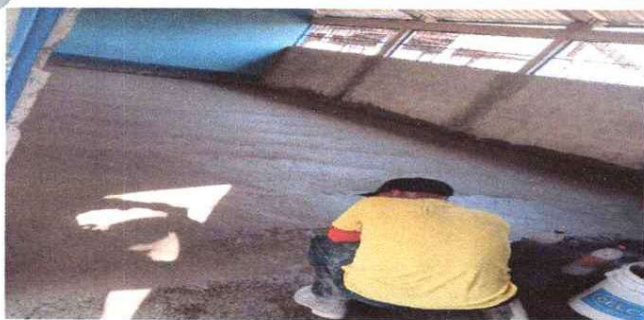
FOTO 5: REMODELACIÓN DE PISO DE CONCRETO.
