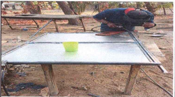
FOTO 4: SUSTITUCIÓN DE PUERTA DE MADERA POR METAL.
