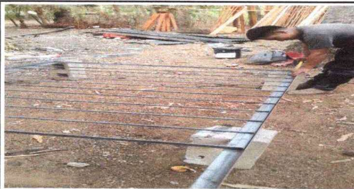
FOTO 3: SUSTITUCIÓN DE VENTANAS DE MALLA POR BALCONES
