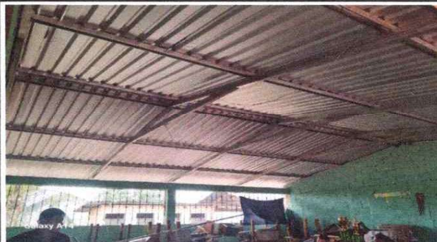
El techo del aula de Tercero
