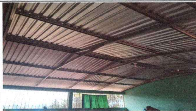
El techo del aula de Segundo
