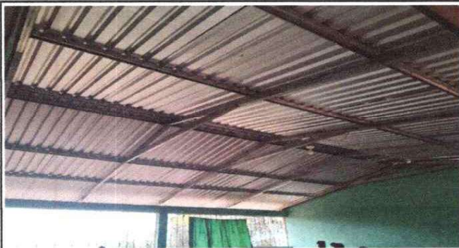
El Techo del aula de Primero
