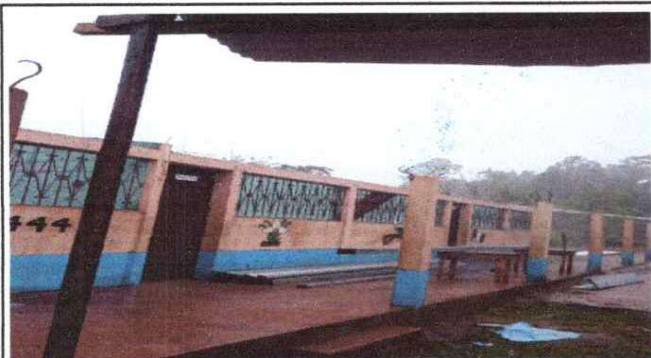
Se Observa que quitaron las laminas existentes y la estructura de madera
