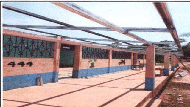
Terminando de armar la estructura metalica
