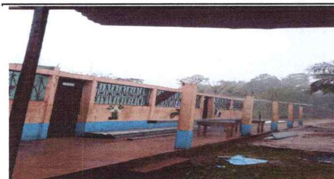
Desinstalacion de las laminas
