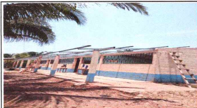
Armando la estructura metalica
