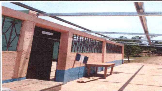
Colocando la estructura metalica
