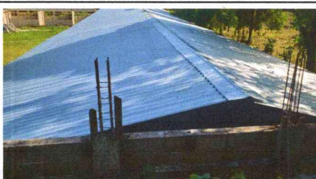
Foto 6 Sustitución de madera por costanera de metal y cubierta de lamina
