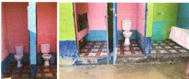
Foto 9 Sustitución de piso de concreto por piso ceramico
