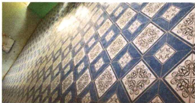
Foto 1 aula No. 1 Sustitución de piso de torta de concreto por ceramico
