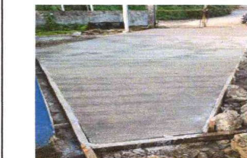
Foto 3 Sustitución de piso torta de concreto
