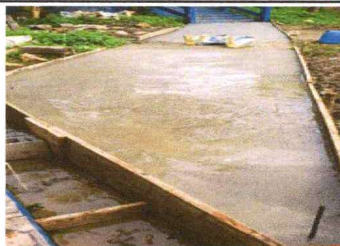
Foto 4 Sustitución de piso torta de concreto
