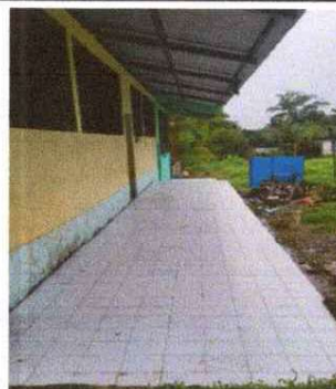
Foto 2 Sustitucion de piso torta de concreto por granito
