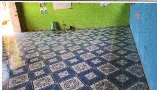
Foto 8 Salon 2 Sustitución de piso de concreto por ceramico
