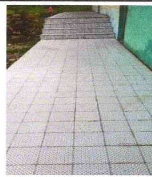
Foto 2 Sustitucion de piso torta de concreto por granito
