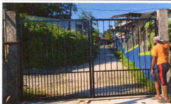
Foto 10 Sustitución de Porton
